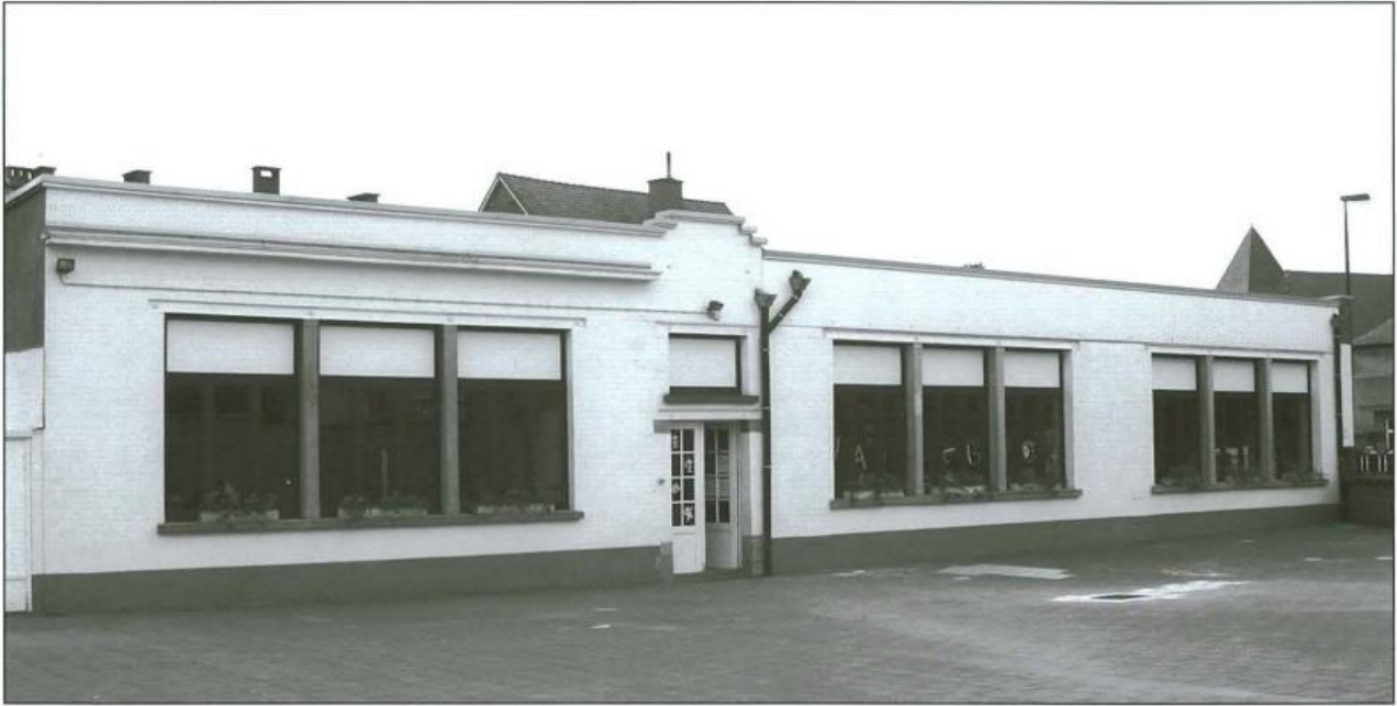
In dit gebouw was de gemeentelijke jongensschool van Beersel gevestigd. Nu wordt het aangevend voor kinderopvang door de "Malleboot".
