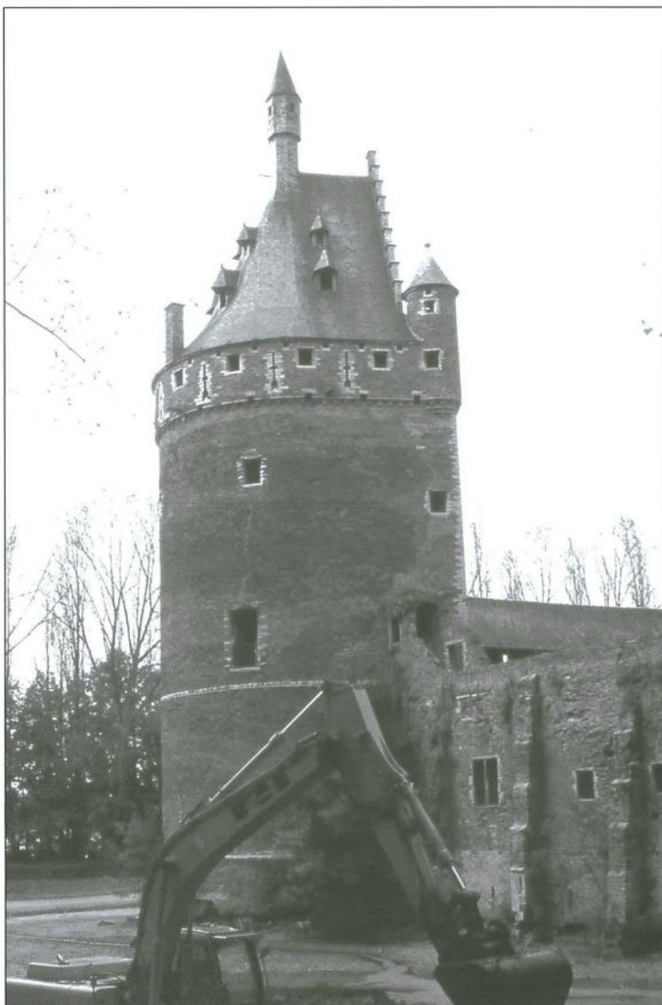
Uitgraven van de slibafzetting in de slotgracht.
